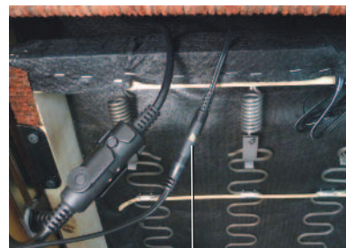
Connexion du transformateur électrique
