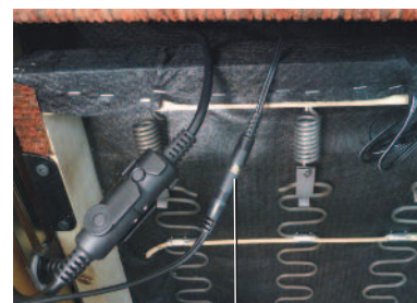
Connexion du transformateur électrique
