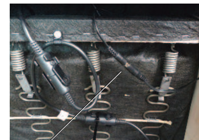
Connexion du transformateur électrique
